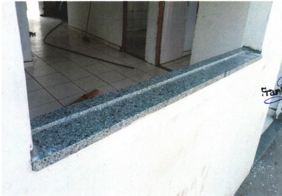
FOTO 25 - PEITORIL LINEAR EM GRANITO OU MÁRMORE, L = 15CM, COMPRIMENTO DE ATÉ 2M, ASSENTADO COM ARGAMASSA 1:6 COM ADITIVO. AF_11/2020
