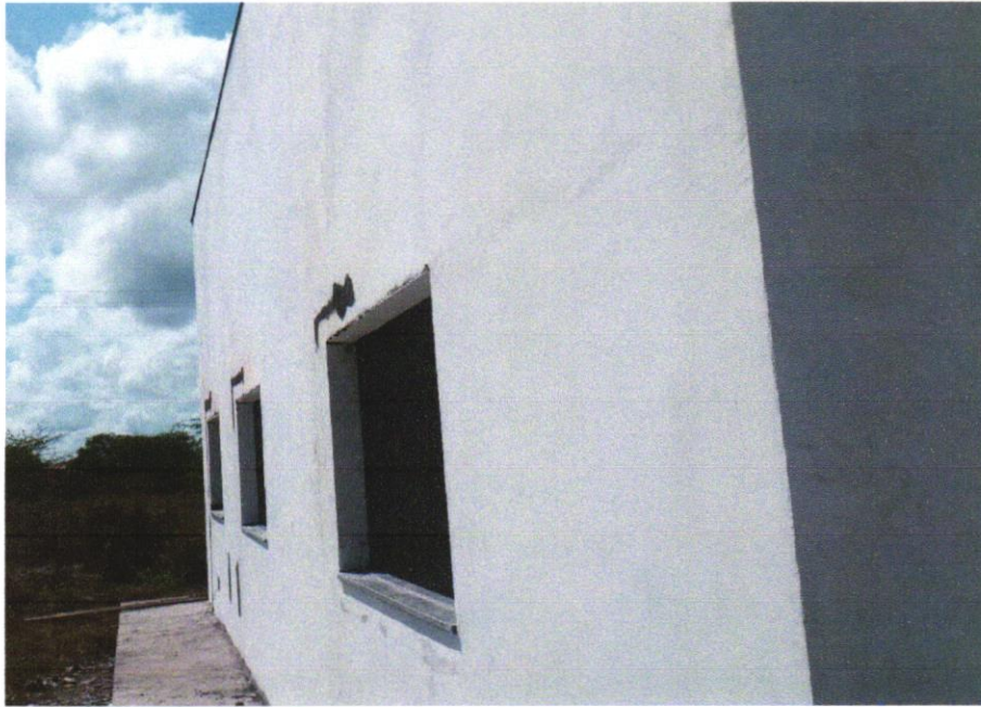
FOTO 27 - APLICAÇÃO E LIXAMENTO DE MASSA LÁTEX EM PAREDES, UMA DEMÃO. AF_06/2014
