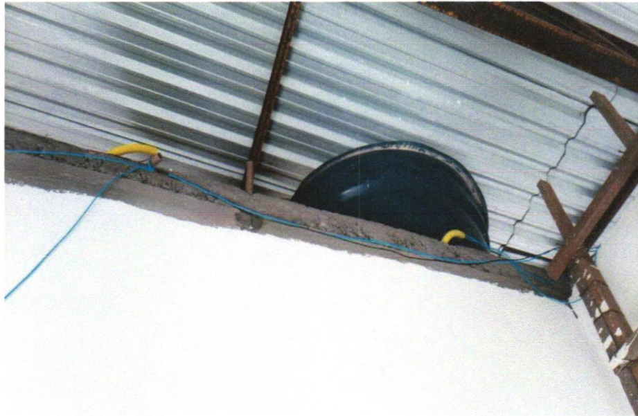
FOTO 11 - CAIXA D'ÁGUA EM POLIETILENO, 500 LITROS - FORNECIMENTO E INSTALAÇÃO. AF_06/2021
