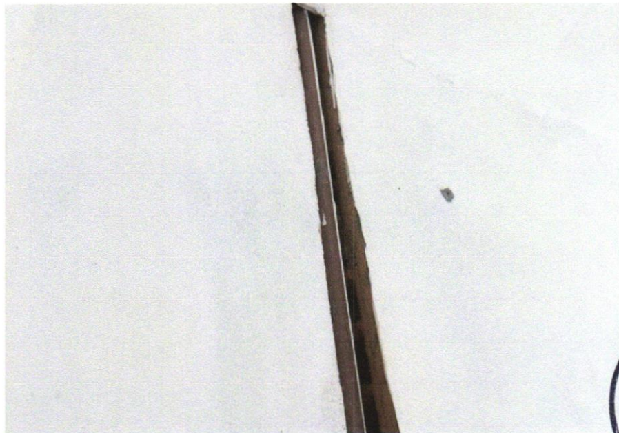
FOTO 12 - TUBO, PVC, SOLDÁVEL, DN 25MM, INSTALADO EM RAMAL OU SUB-RAMAL DE ÁGUA - FORNECIMENTO E INSTALAÇÃO. AF_06/2022
