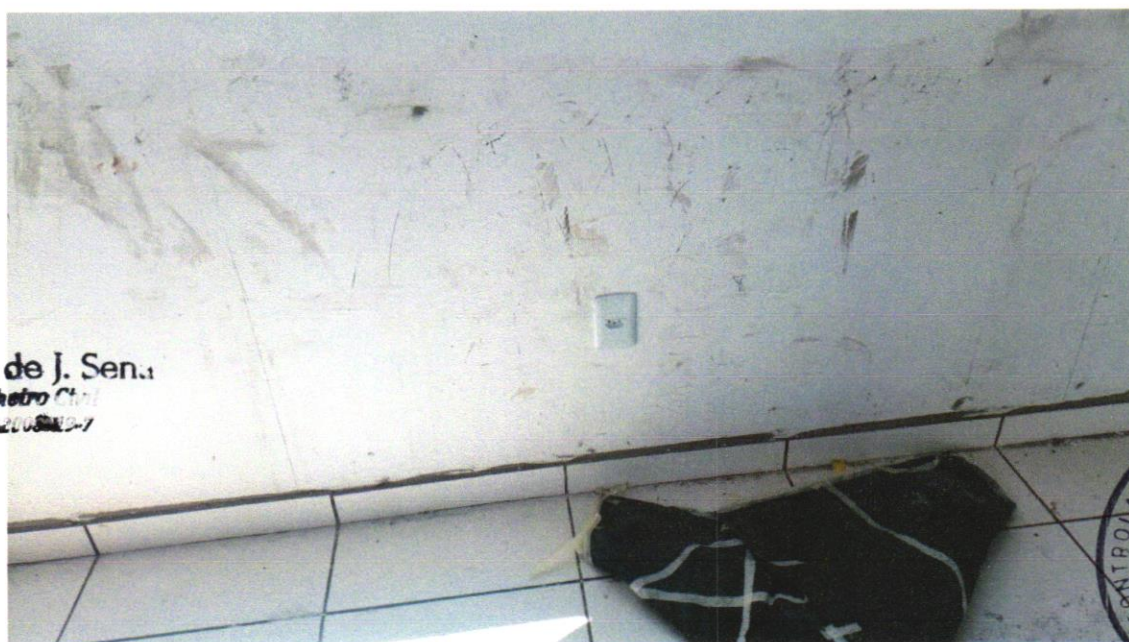
FOTO 08 - TOMADA BAIXA DE EMBUTIR (1 MÓDULO), 2P+T 10 A, INCLUINDO SUPORTE E PLACA - FORNECIMENTO E INSTALAÇÃO. AF_12/2015
