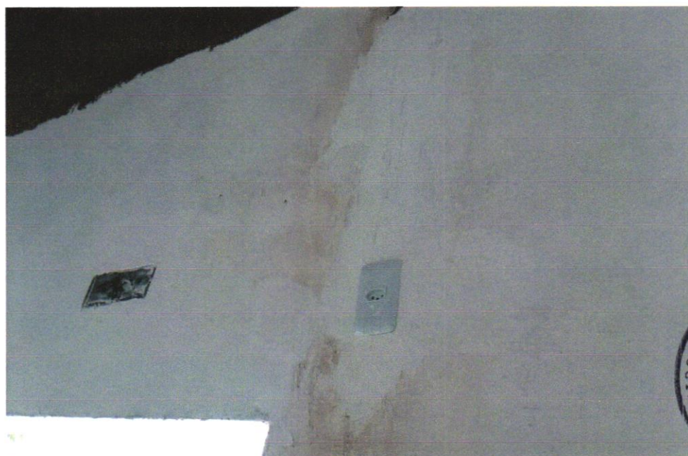
FOTO 10 - TOMADA ALTA DE EMBUTIR (1 MÓDULO), 2P+T 20 A, INCLUINDO SUPORTE E PLACA - FORNECIMENTO E INSTALAÇÃO. AF_12/2015
