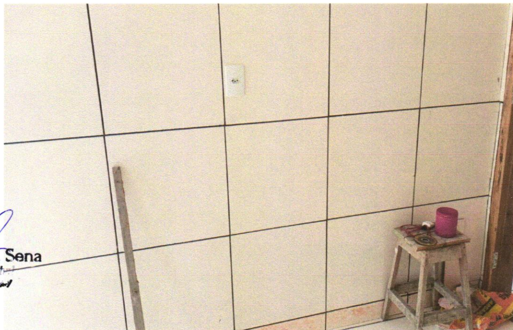
FOTO 19 - REVESTIMENTO CERÂMICO PARA PAREDES INTERNAS COM PLACAS TIPO ESMALTADA EXTRA DE DIMENSÕES 33X45 CM APLICADAS EM AMBIENTES DE ÁREA MAIOR QUE 5 M 2 A MEIA ALTURA DAS PAREDES. AF_06/2014
