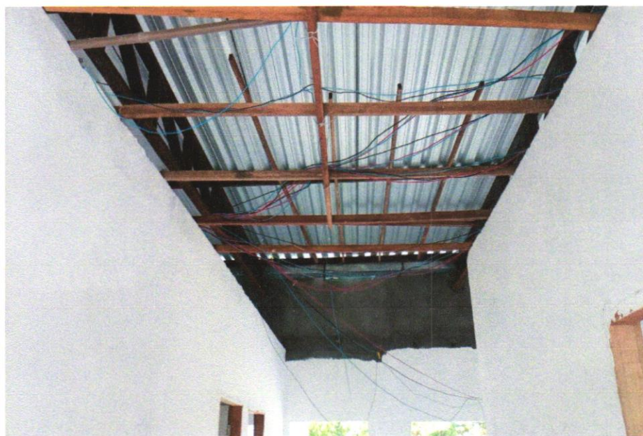
FOTO 05 - CABO DE COBRE FLEXÍVEL ISOLADO, 2,5 MM 2 , ANTI-CHAMA 450/750 V, PARA CIRCUITOS TERMINAIS - FORNECIMENTO E INSTALAÇÃO. AF_12/2015
