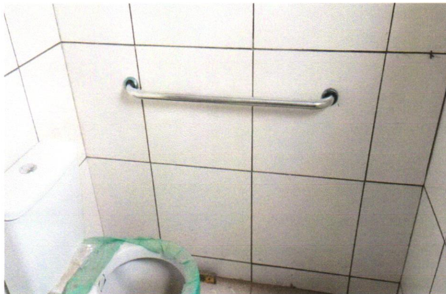
FOTO 29 - BARRA DE APOIO RETA, EM ALUMINIO, COMPRIMENTO 60 CM, FIXADA NA PAREDE - FORNECIMENTO E INSTALAÇÃO. AF_01/2020
