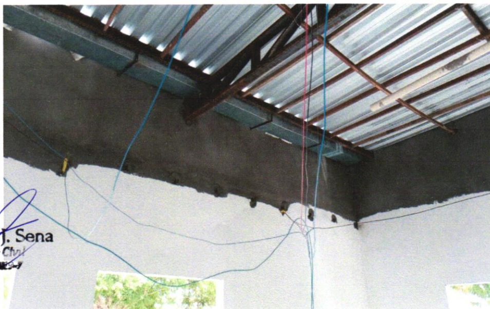
FOTO 06- CABO DE COBRE FLEXÍVEL ISOLADO, 4 MM 2 , ANTI-CHAMA 0,6/1,0 KV, PARA CIRCUITOS TERMINAIS - FORNECIMENTO E INSTALAÇÃO. AF_12/2015
