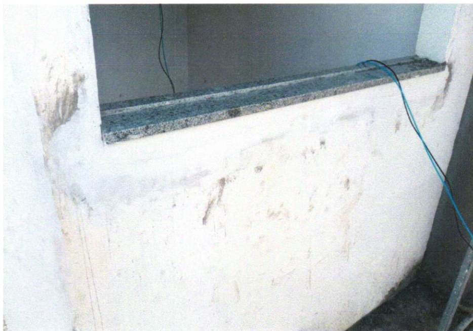
FOTO 26 - PEITORIL LINEAR EM GRANITO OU MÁRMORE, L = 15CM, COMPRIMENTO DE ATÉ 2M, ASSENTADO COM ARGAMASSA 1:6 COM ADITIVO. AF_11/2020
