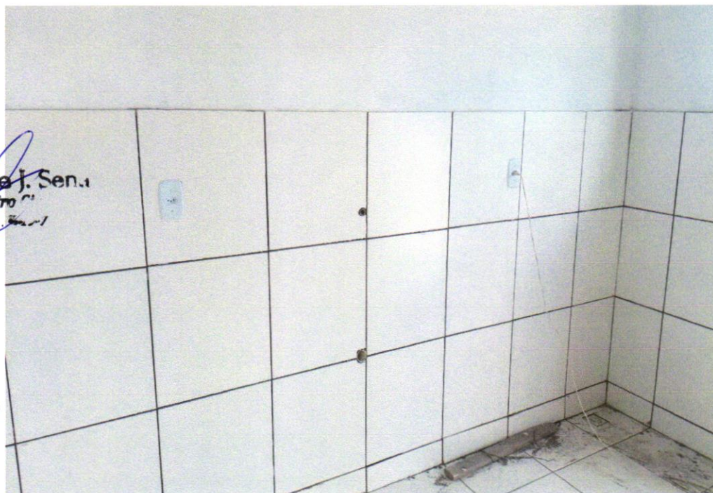
FOTO 09 - TOMADA MÉDIA DE EMBUTIR (1 MÓDULO), 2P+T 10 A, INCLUINDO SUPORTE E PLACA - FORNECIMENTO E INSTALAÇÃO. AF_12/2015
