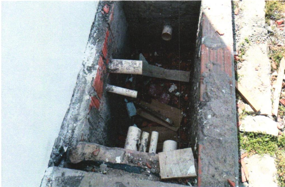
FOTO 13 - TUBO DE PVC BRANCO PARA REDE COLETORA DE ESGOTO CONDOMINIAL DE PAREDE MACIÇA, DN 100 MM, JUNTA ELÁSTICA - FORNECIMENTO E ASSENTAMENTO. AF_01/2021
